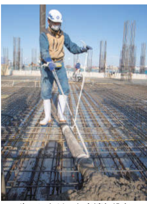
生コンクリートを流し込む平和圧送の社員
