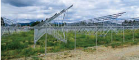
<施行中>発電システムの骨組みと、侵入防止柵などを設置。同時に敷地内緑地化のための準備も進めます
