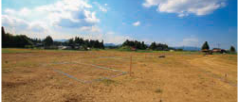
<造成後>まず現地調査を行います。活用可能と診断されれば、木々の伐採などを含めた整地に入ります
