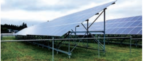
＜完成＞最後に太陽光集積パネルを取り付けた後、監視システムやデータ計測のモニターを設置して完了
