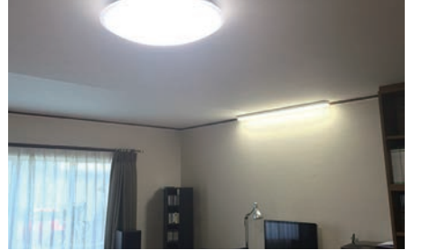
モニターへの写り込みも計算された照明の配置
